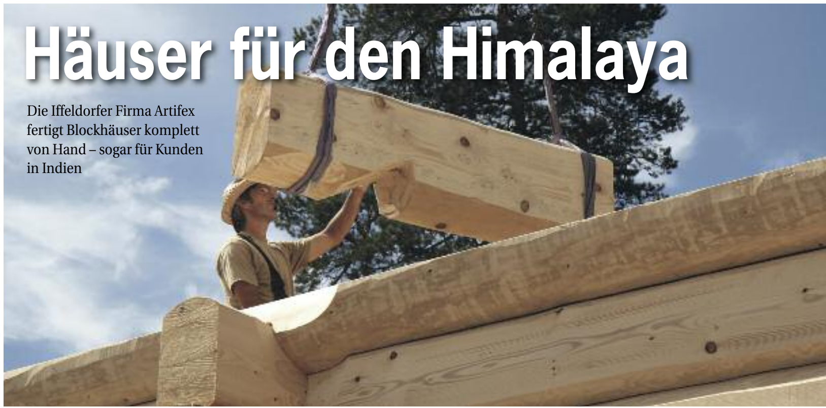
Perfekte Technik: Die einzelnen Holzteile werden mit einem Kran aufeinandergesetzt.
