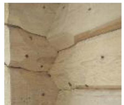
Hält ewig: Per Sattelkerbe werden die besäumten Stämme an den Ecken miteinander verbunden.
